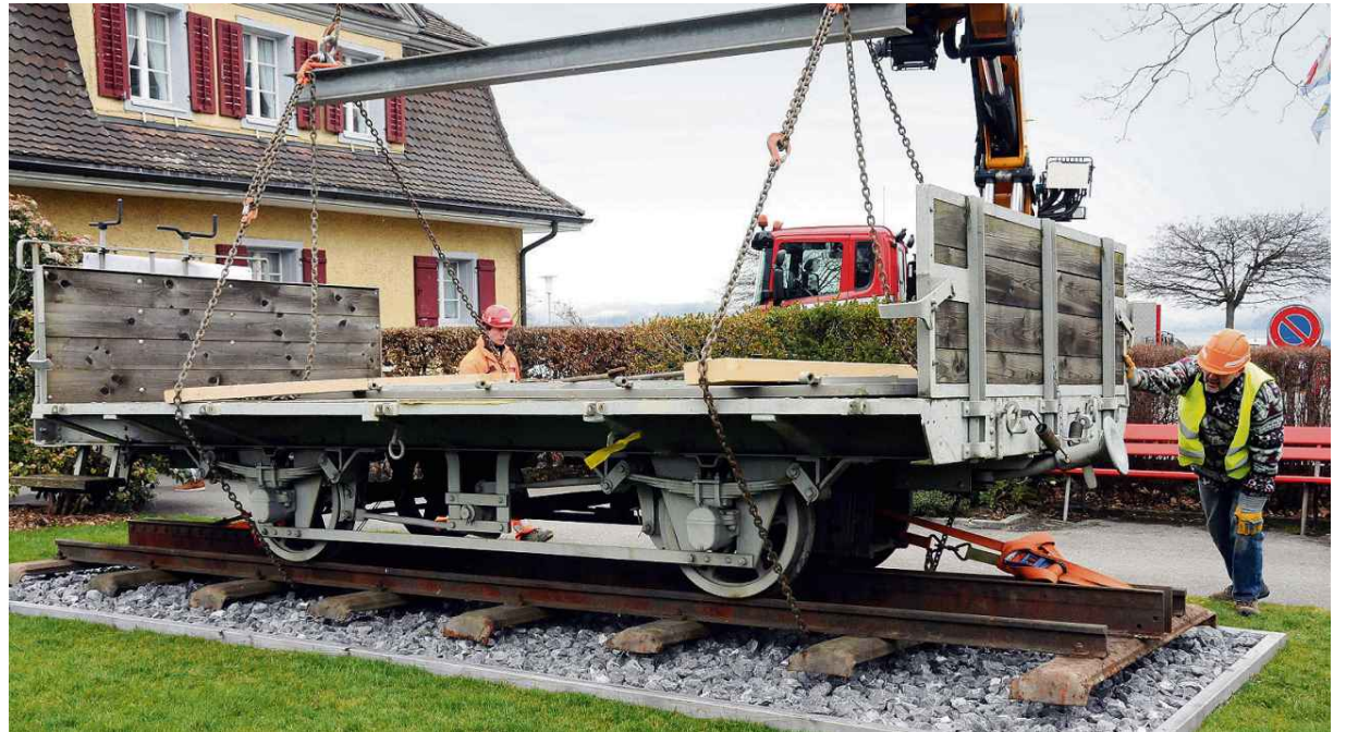
Mit Hilfe eines Krans wird der Güterwagen L 30 mitsamt Gleisabschnitt auf ein Bett aus Schottersteinen gehievt.
